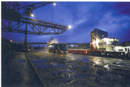
Am Hauptsitz in Duisburg laufen verschiedene Verkehrsträger zusammen – auch bei Nacht
