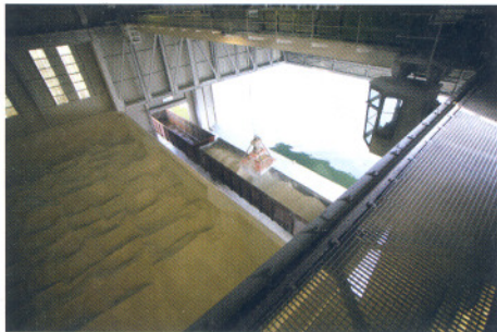
Am Standort Dortmund ist ein vollständig überdachter Schüttgut-Umschlag möglich | Bilder: Ruhrmann
