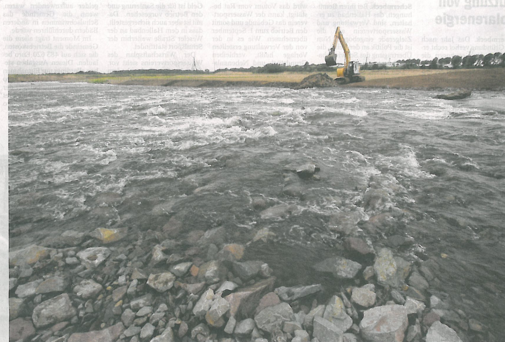
Mit vielen Steinen, einem Bagger und Kipper wurde die Lippe verändert.
