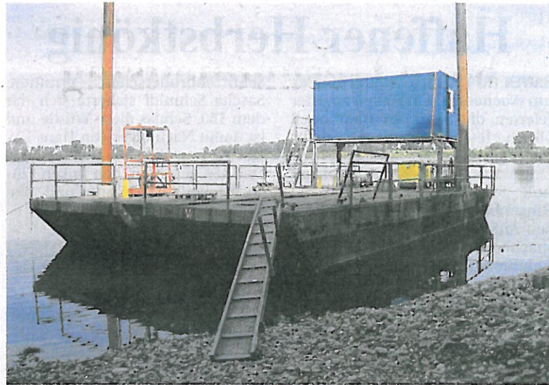
Von dieser Plattform aus erfolgten die Probebohrungen im See.
