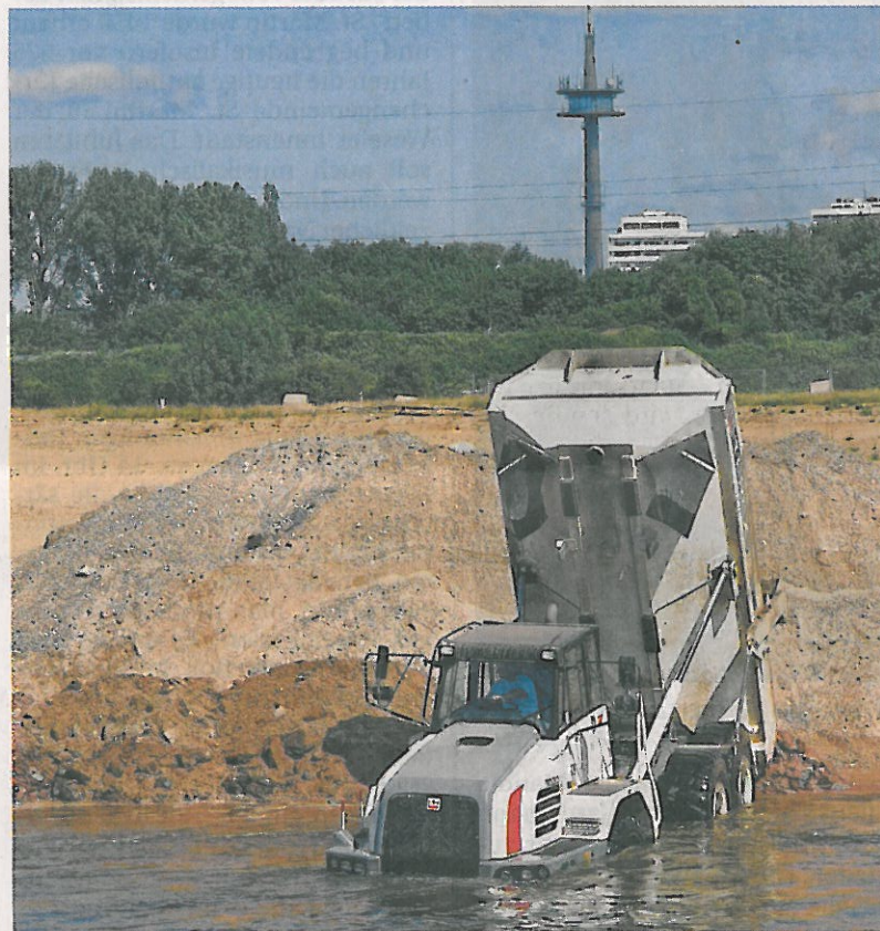
Spezial-Lkw schütten unweit des Lippeschlösschens Felsgestein in die Lippe. Durch das sogenannte „Übergangsprofil“ wird der Fluss ein wenig zurückgestaut .
