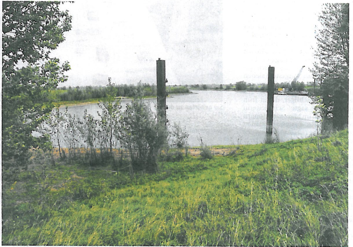
Der alte Kiesverladehafen von Hülskens liegt am Rhein zwischen Lüttingen und Wardt. Hier sollte das Baumaterial für den Deich angelandet und über eine Baustraße zur Deichbaustelle gefahren werden. Damit sollte Wardt vom Lkw-Verkehr entlastet werden. Das ist fraglich, weil dort vor kurzem eine Rauhautfledermaus gesichtet wurde. RP-FOTO: 00
